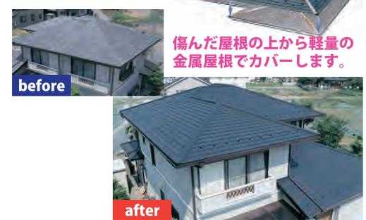
傷んだ屋根の上から軽量の金属屋根でカバーします。
